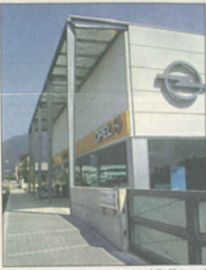
Galvauto S.r.l., una veduta della facciata dell'edificio con il portico.
