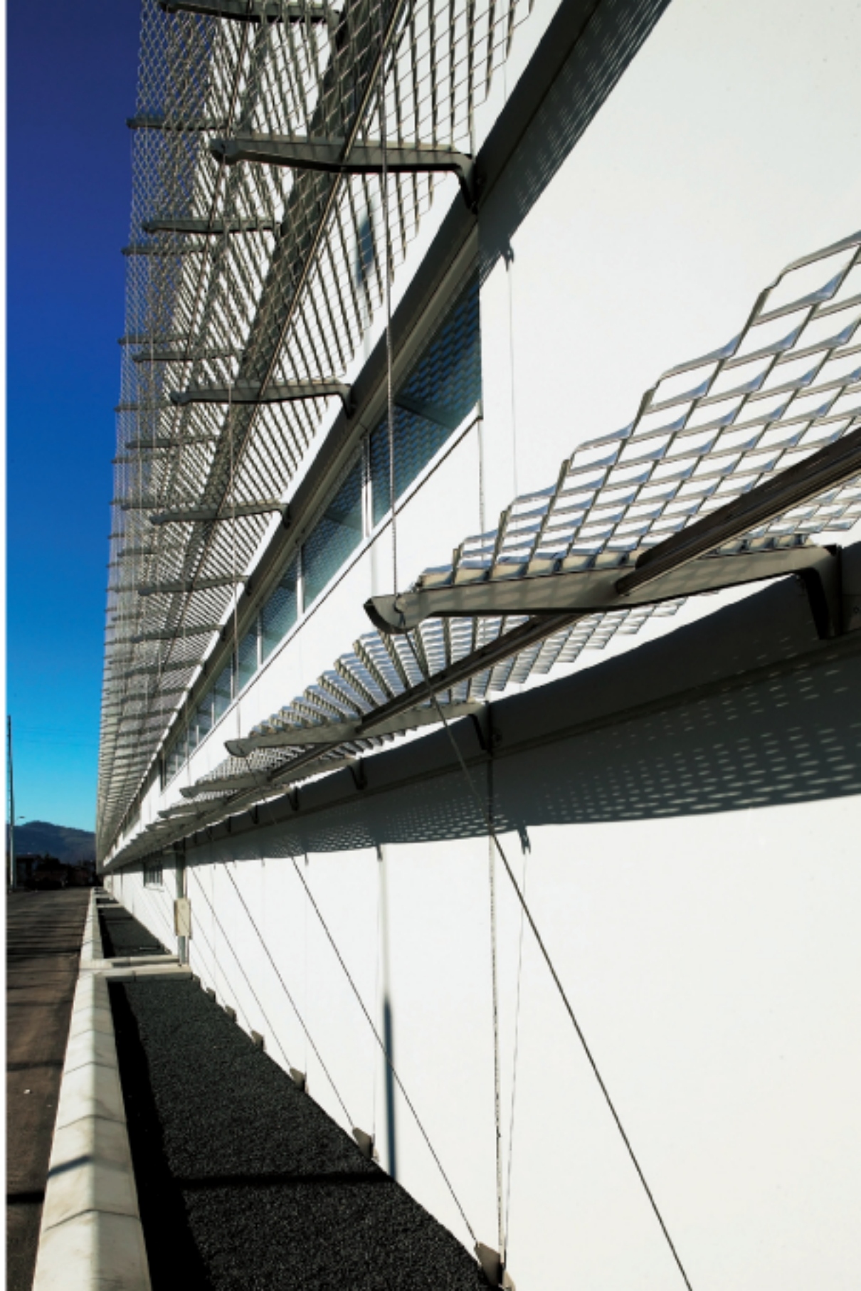
I frangisole della facciata sud del fabbricato Telwin di Villaverla (VI).
